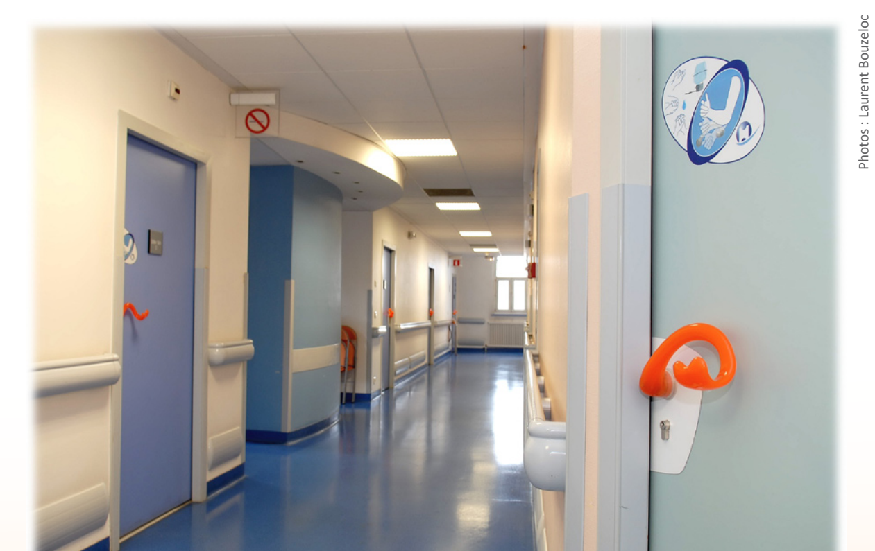
44 portes du Service de Maladies Infectieuses et Tropicales équipées avec les poignées Ulna
